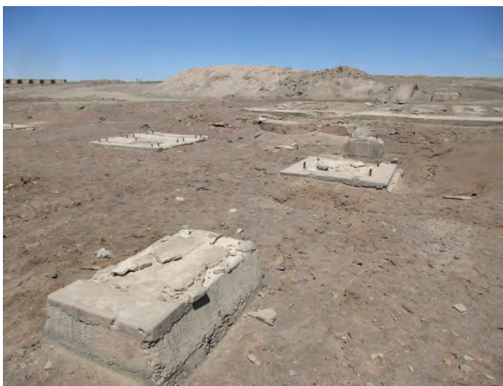
Figura 8. Detalles de las estructuras de concreto que servían de base y soporte a las bombas de la oficina Cecilia.
