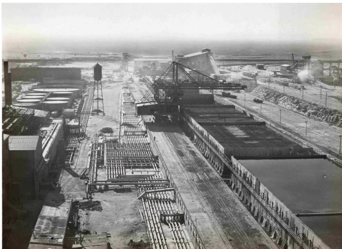
Figura 9. Vista de los estanques de lixiviación, puentes de descarga y chancado de la planta de Coya Norte, diseñada por Skougør y Apolant. Archivo del autor.
