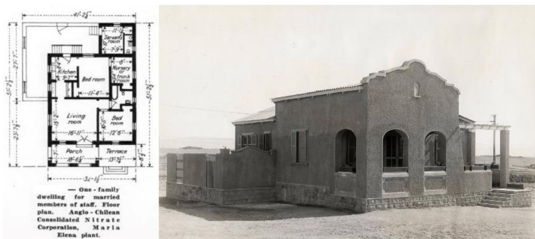
Figura 15. Plano de chalet "A" de Coya Norte, de autoría de Skougor y publicado por Hubbell (1933). Fotografía del chalet 118 del archivo del autor.
