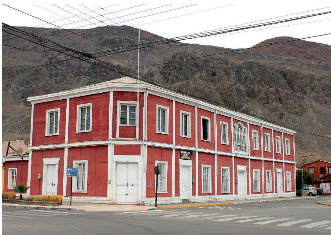
Fotografía 23. Edificio museo Augusto Capdeville, vista actual. Fuente: Museo Augusto Capdeville, Taltal
